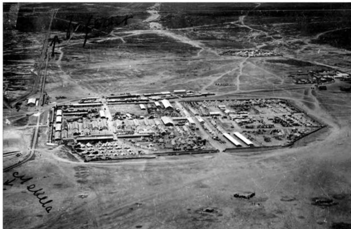
Campament y població de Dar Drius provincia de Driouch, març de 1924 Macià Ferrando Roca
