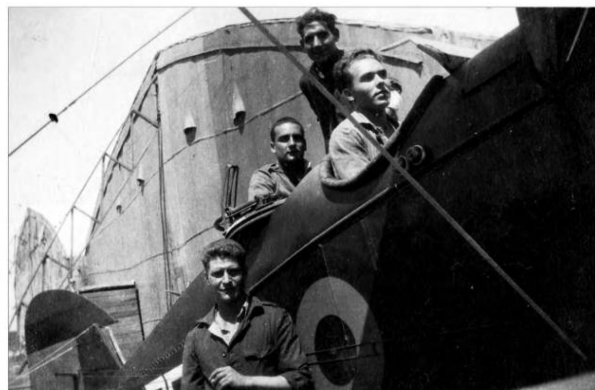
"Provant" un avió Aeròdrom de Nador, 1924 Macià Ferrando Roca
