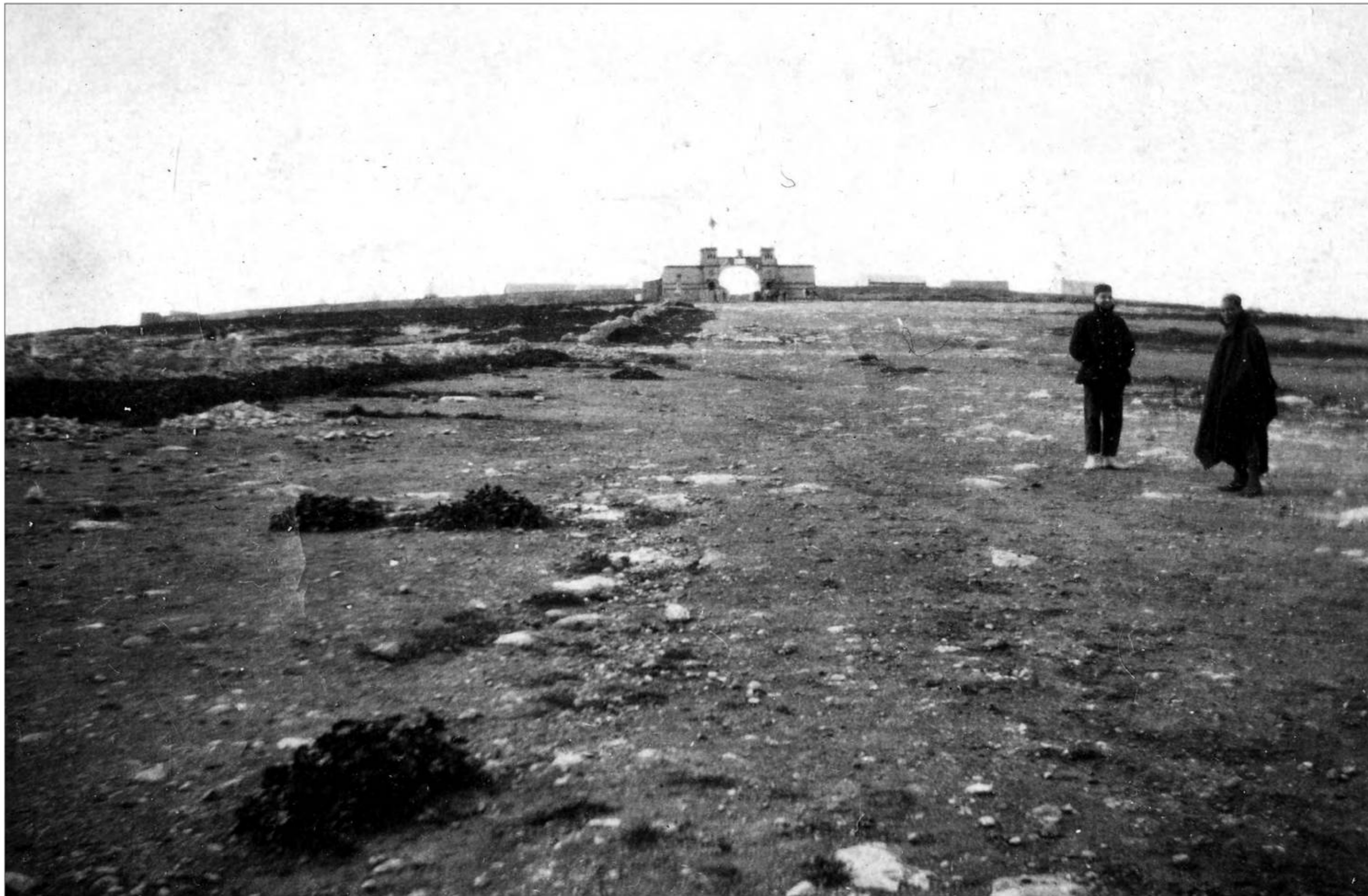
Exterior del campament de Mont Arruit Febrer de 1924 Macià Ferrando Roca
